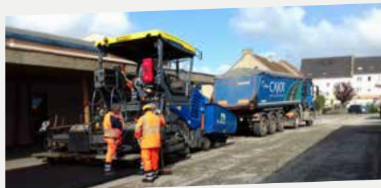
pose des enrobés
