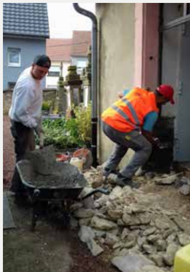
mise en place de l'issue de secours
