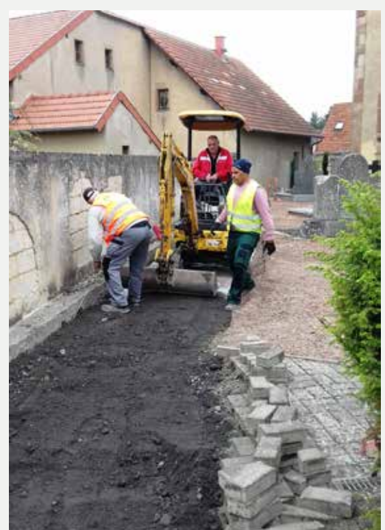
travaux accès cimetière
