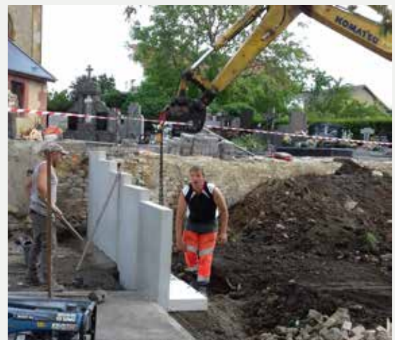
pose du mur de soutènement
