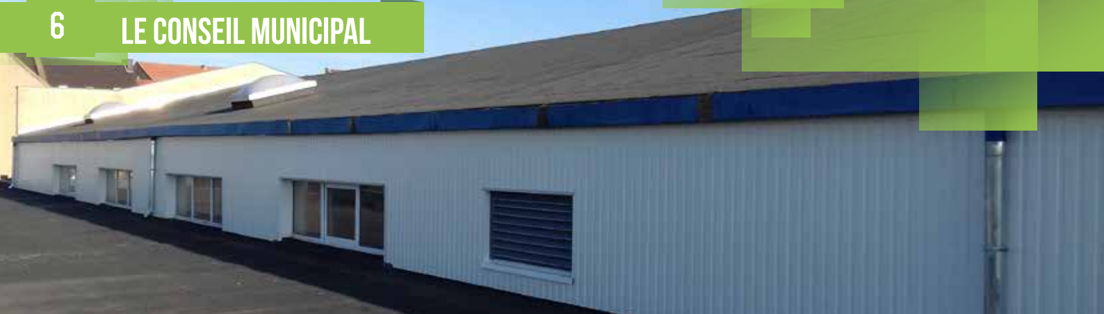
travaux d'étanchéité pose bardage
