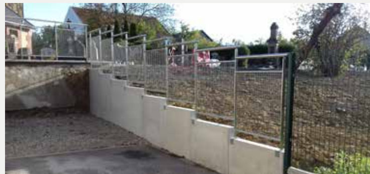
clôture en partie basse et garde-corps inox
