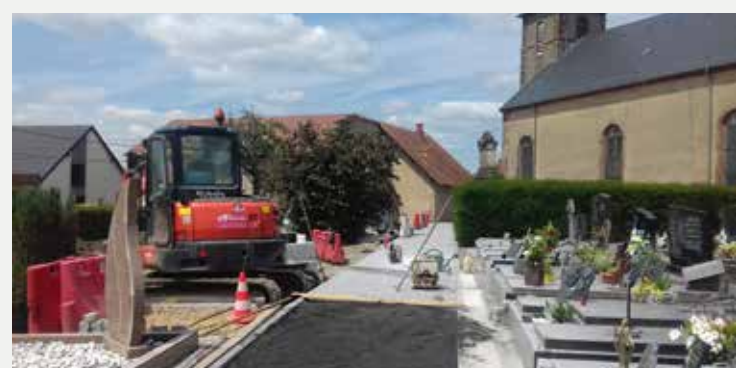
travaux chemin du cimetière pose de pavés
