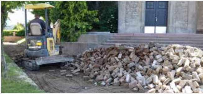
dépose des pavés devant le parvis
