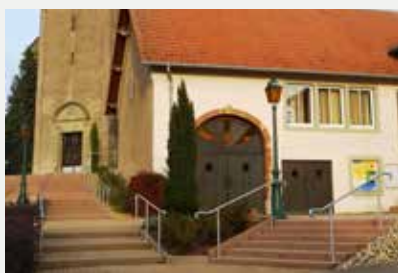
garde corps Mairie et église
