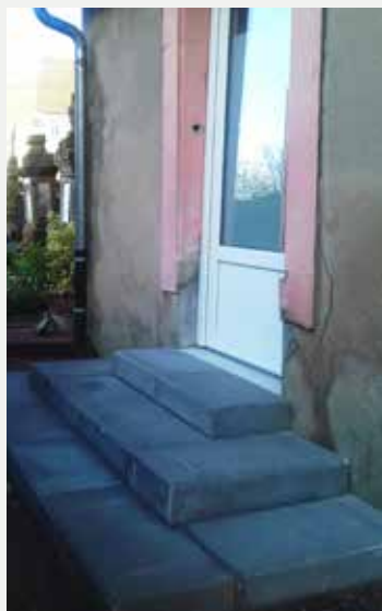
mise en place porte de secours
